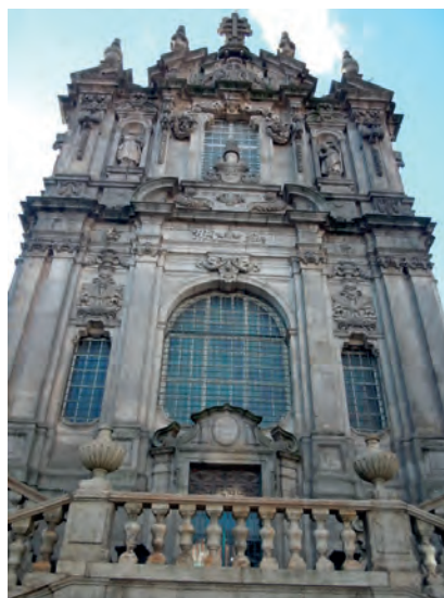
Figura 2 – Nicolau Nasoni, Igreja dos Clérigos , Porto, 1731-1763, fachada
